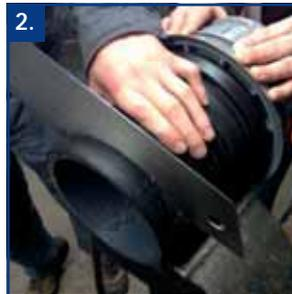
2. Wanddicke des Stahlbetonrohres an der schmalsten Stelle des Bohrkerns messen und den Stutzen dementsprechend bauseits ablängen. (z.B. handelsüblicher Fuchsschwanz mit einem für Kunststoff geeignetem Sägeblatt)
