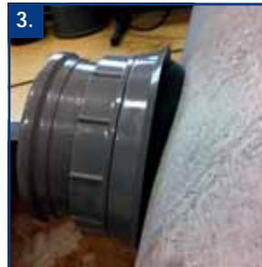
3. Nachdem die Dichtung mit einem Gleitmittel eingeschmiert wurde, wird der Stutzen per Hand in das Bohrloch geschoben.
