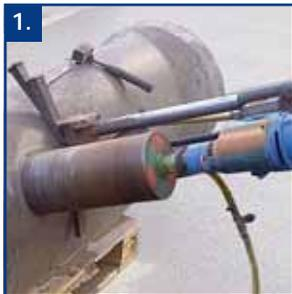
1. Kreisloch mit Diamant Bohrkronen rechtwinklig und zentrisch zur Rohrachse bohren. Bohrlochdurchmesser: 165,0 – 166,5 mm
