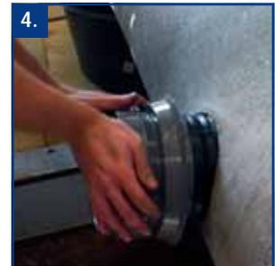
4. Durch das Anziehen der Rändelmutter mit dem Montageschlüssel von Pipelife wird die Dichtung mit dem Rohr verpresst. Der Stutzen dichtet zuverlässig ab. Passender Montageschlüssel Art. Nr. 1195 0018 00
