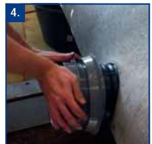
4. Durch das Anziehen der Rändelmutter mit dem Montageschlüssel von PIPELIFE wird die Dichtung mit dem Rohr verpresst. Der Stutzen dichtet zuverlässig ab.
