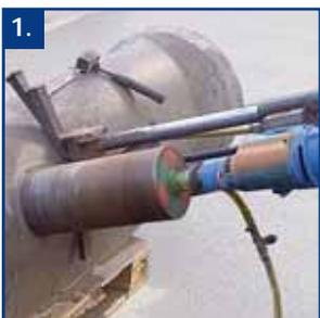
1. Kreisloch mit Diamant Bohrkronen rechtwinklig und zentrisch zur Rohrachse bohren.
