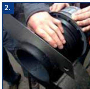
2. Wanddicke des Stahlbetonrohres an der schmalsten Stelle des Bohrkerns messen und den Stutzen dementsprechend bauseits ablängen. (z.B. handelsüblicher Fuchschwanz mit einem für Kunststoff geeignetem Sägeblatt)
