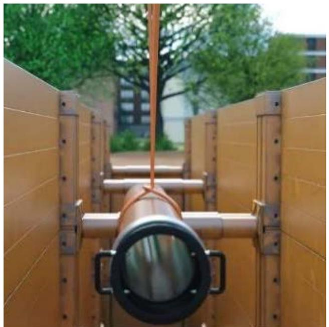
Grundsätzlich sind für den Einbau der KERA.iXP Rohre und der zugehörigen Formstücke stets das original iX.LUBE Gleitmittel sowie der Installationsadapter iX.FIX zu verwenden.
