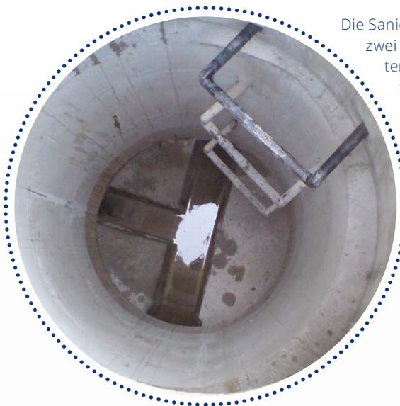
Die Sanierung von Schächten mit unserem DURA.PC-System erfolgt in der Regel in zwei Schritten. Zunächst wird der Schachtboden mit entsprechend zugeschnittenen Halbschalen und vorgefertigten Bermenplatten aus Polymerbeton wiederhergestellt.
