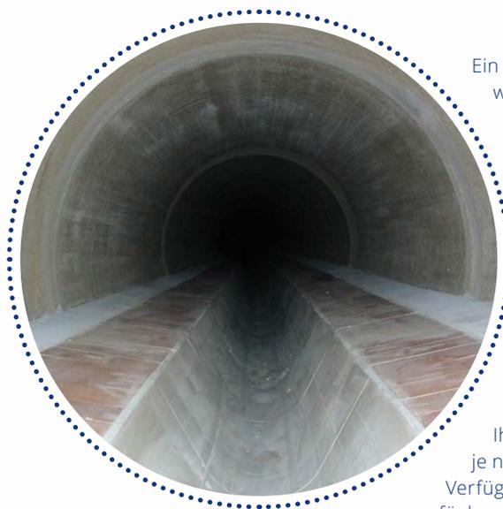
Ein gängiges Beispiel für Kanalsanierung ist die Auskleidung der Sohle mit dünnwandigen, korrosionssicheren Schalen. Diese Form der Sanierung eignet sich besonders für Kanäle mit rechten oder sogar spitzen Winkeln im Querschnitt. Die Sanierungsprofile werden erst im Kanal zusammengefügt und dort verklebt. So können die Elemente durchaus auch ohne Baugruben durch enge Schächte in den Kanal gebracht werden.
